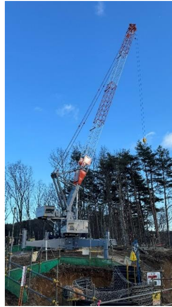
ジブクレーン
